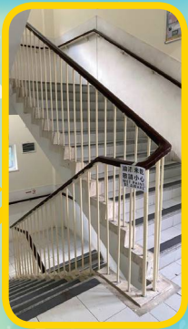
樓梯間扶手油漆工程
